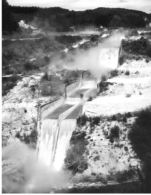
Resim 3. Maksimum Çökme Bölgesine Yakın Wairakei Sulama Kanalı (sıcak-su drenaj kanalı) [8].
