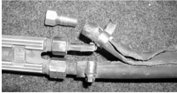
Şekil 4. Alev geri tepmesi sonrasında oluşan durum
