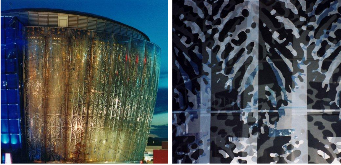
Şekil 2. Duales System Expo 2000 Pavyonu. Solda: ETFE cephe. Sağda: ETFE yastık katmanları üzerindeki baskılı yaprak dokusu
