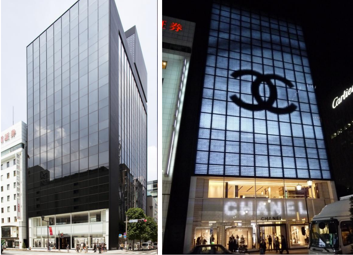
Şekil 4. Chanel Ginza binası cephesi. Solda: Gündüz durumu - saydam cephe. Sağda: Gece durumu – opak medya ekranı
