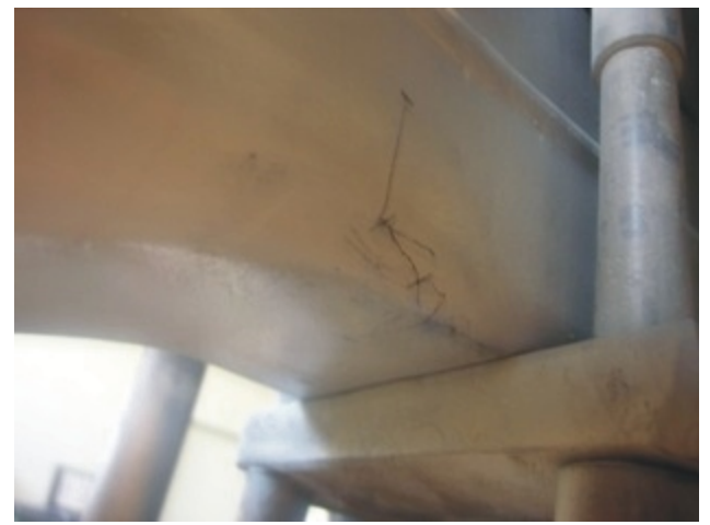
Şekil 4. Test Numunesinde Oluşan Yorulma Çatlakları
