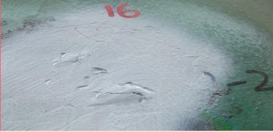
Fotograf 16. Depolama Tankı Üzerinde Uygun Olmayan Tadilat Sonrası Meydana Gelen Çatlaklar
