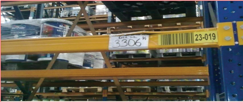
Fotograf 13. Yanlış Kullanımdan Kaynaklanan Plastik Deformasyon
