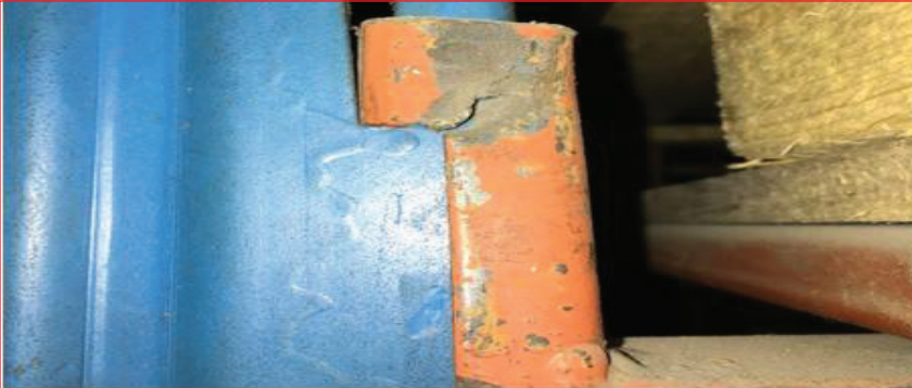
Fotograf 14. Korozyonlu Bölgede Tespit Edilen Çatlak
