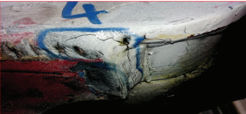
Fotograf 15. Üretim Hatasından Kaynaklanan Çatlaklar
