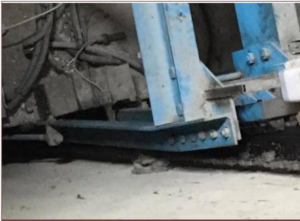
Fotoğraf 1. Asansör Taşıyıcı Sisteminin Deprem Sonrası Durumu
