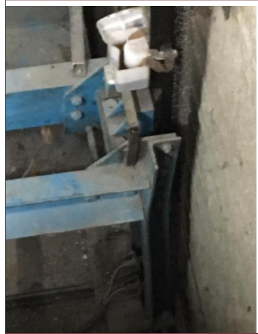
Fotoğraf 2. Süspansiyon Eğilmesinin Raylara Etkisi
