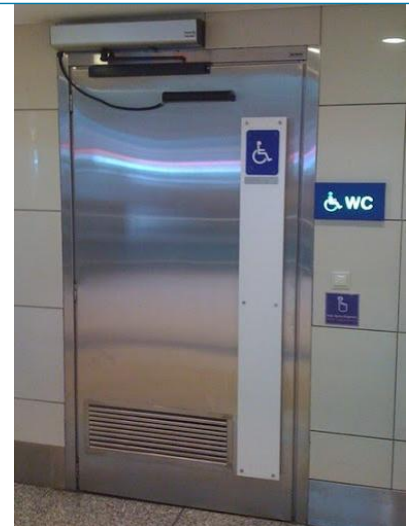
Şekil 32. Hidrolik Kapı (El Değmeden Çalışan)
