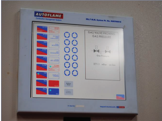
Fotoğraf 7. Otomatik Gaz Sızdırmazlık Kontrolü Cihazı İçindeki Gaz Basıncı
