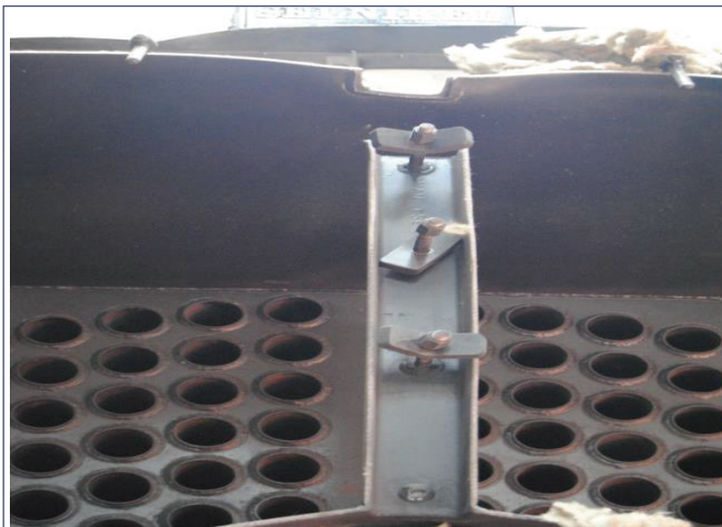
Fotoğraf 8. Ön Duman Kapakları, Orta Bağlama Noktası Lamaları
