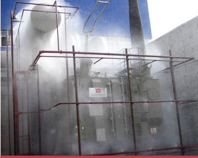
Şekil 3. Sulu-Köpüklü Söndürme Sistemi
