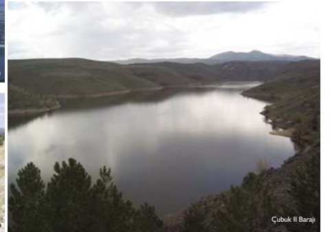
Çubuk II Barajı
