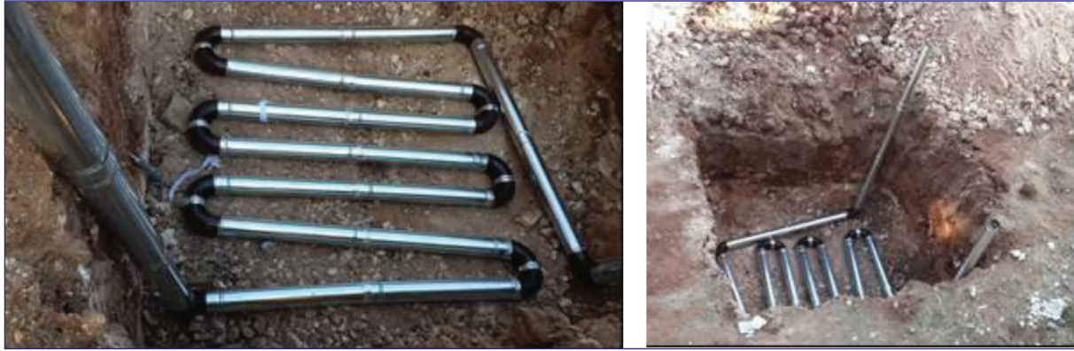
Şekil 4. THID Sisteminde Boruların Yerleştirilmesi
