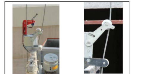
Resim 5. Blok Stop İkincil Teçhizat [5]
