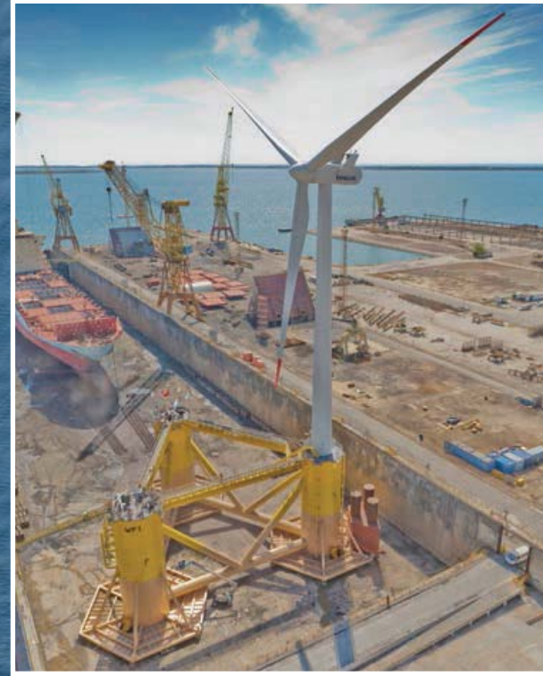
Portekiz'deki Setubal yakınlarında testlere tabi tutulan bir WindFloat platformu prototipi Lisnave tesisindeki bir havuza inşa edildi
