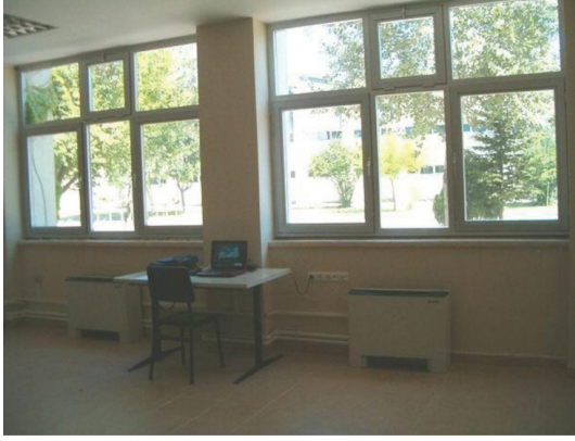
Şekil 2. Konfor Odası ve Isı Dağıtım Sistemi [10]
