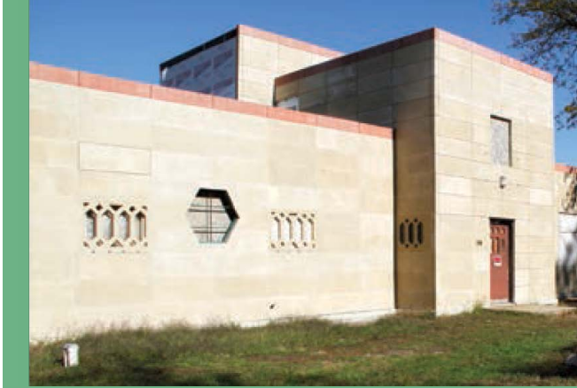
Florida Tropikal Evi (üstte) flamingo pembesiydi ve kasırgalara dayanacak şekilde tasarlanmıştı. Wieboldt-Rostone Evi'nin (altta), dış cephesinin çürümesinin ardından tekrar kaplanması gerekti.
