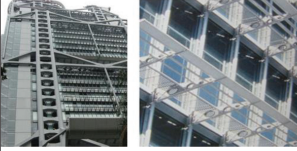
Şekil 4. Hong Kong ve Shanghai Bankası, Güneş Kırıcı Paneller, Hong Kong [10]
