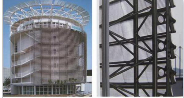
Şekil 7. Siemens Pavyonu, Hareketli Yatay Kepenkler, İspanya, 1992 [8]
