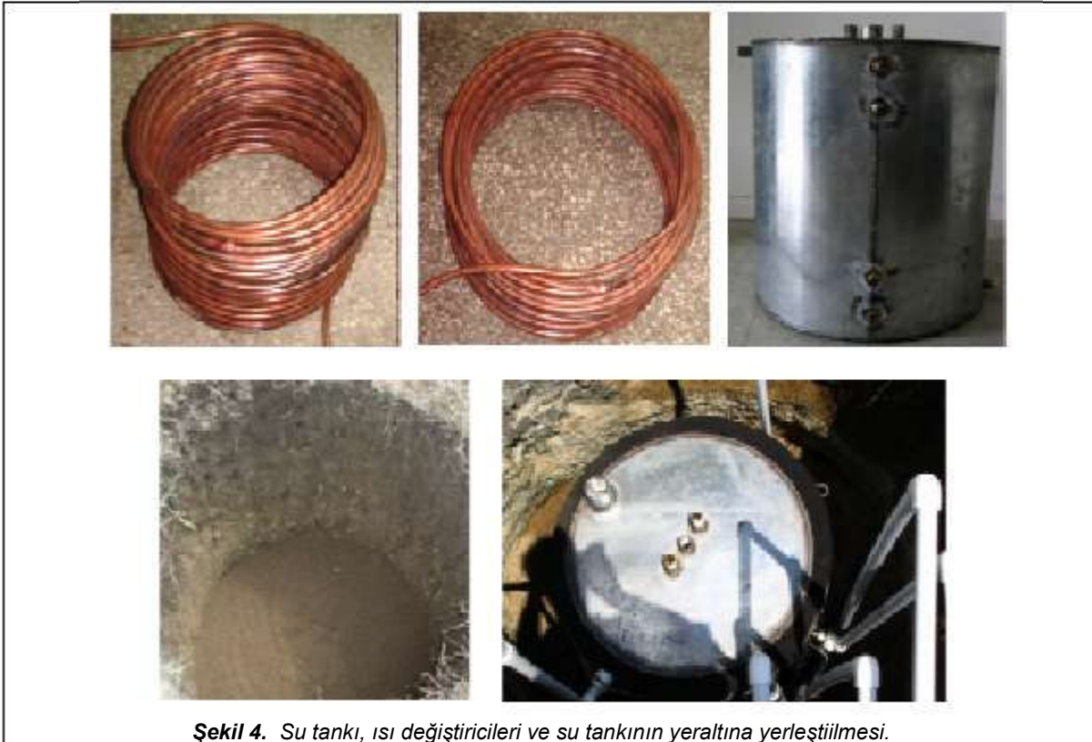
Şekil 4. Su tankı, ısı değiştiricileri ve su tankının yeraltına yerleştirilmesi.
