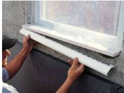
Resim 9. Denizlik Profili ve Uygulama Örneği
