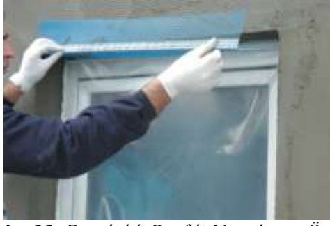
Resim 11. Damlalık Profili Uygulama Örneği
