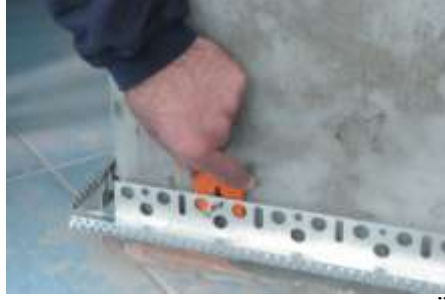
Resim 7. Subasman Profili Uygulama Örneği
