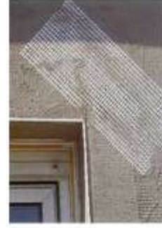
Resim 12. Donatı Filesi ve Yüzey Sıvası Uygulama Örnekleri
