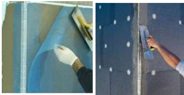
Resim 10. Köşe Profili Uygulama Örneği
