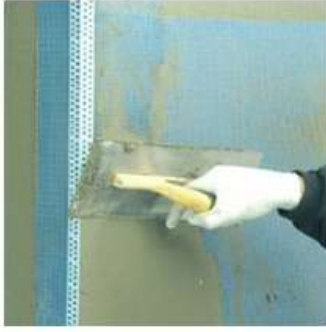
Resim 12. Donatı Filesi ve Yüzey Sıvası Uygulama Örnekleri
