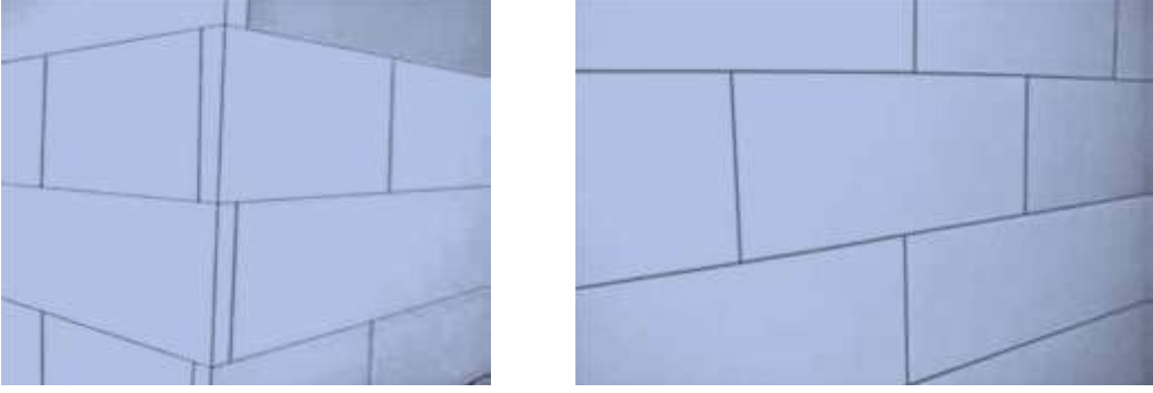
Şekil 4. Yalıtım Levhasının Köşe ve Düz Yüzeyle Uygulama Örneği
