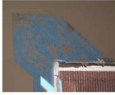
Resim 12. Donatı Filesi ve Yüzey Sıvası Uygulama Örnekleri
